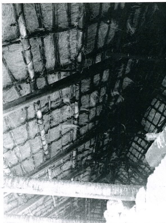
Foto N° 07: Detalle de estructura de cubierta de madera y cobertura de paja de la cubierta de Fuente: Ficha de Inventario IBI-15-03-50-000-000001, INPC, 2014.
