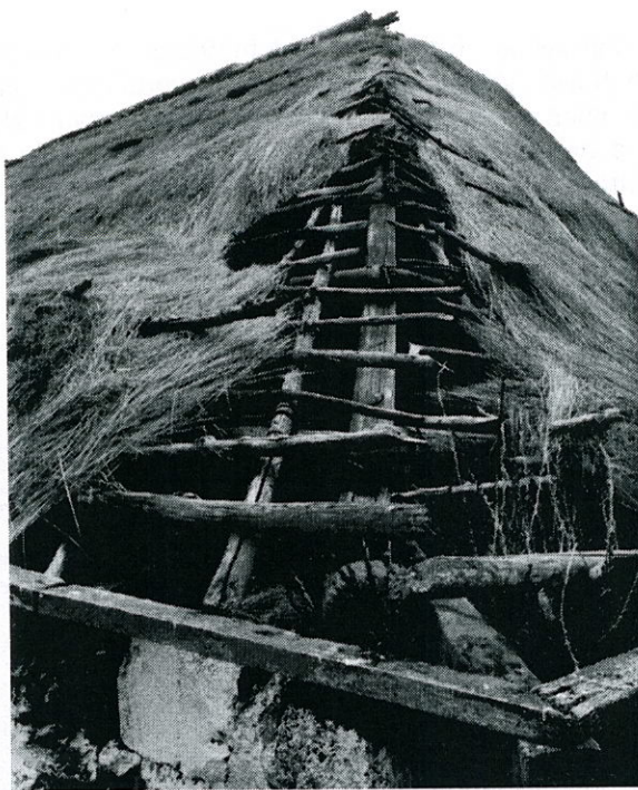
Foto N° 06: Detalle de estructura de cubierta de madera y cobertura de paja de la cubierta de Fuente: Ficha de Inventario IBI-15-03-50-000-000001, INPC, 2014.
