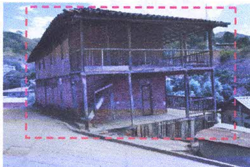
FOTOGRAFÍA NRO. 2. Edificación inventariada de la ciudad de Portovelo.
