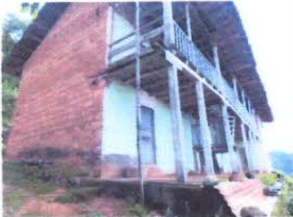
Fotografía 4: Detalle de sistema constructivo de edificación
