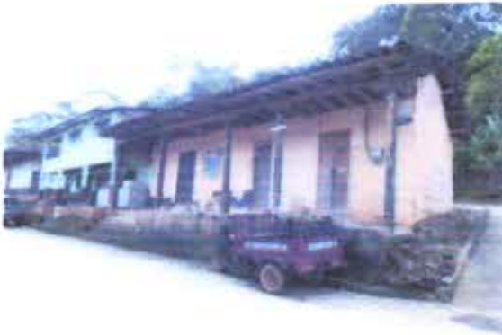
Fotografía 2: Tramo Mz 12. Calle 21 de mayo
