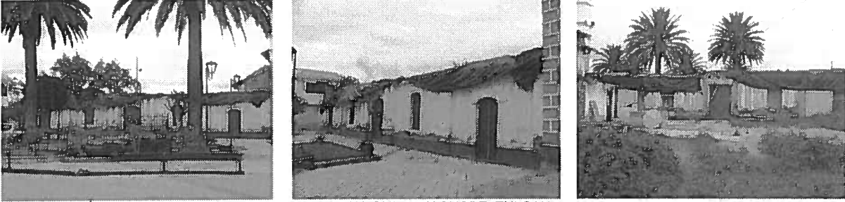
2.-INSPECCIÓN INMUEBLE UBICADO EN LA CALLE TARQUI 365 Y SUCRE, TULCAN
