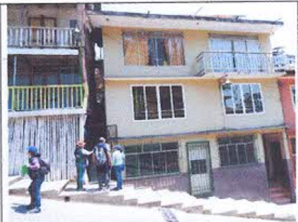
Fotografía nro. 2: Recorrido de los técnicos del INPC R7 con acompañamiento de los técnicos del GADM Zaruma Fuente: INPC R7
