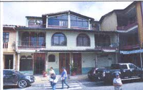
Fotografía nro. 3: Levantamiento de fichas de evaluación de daño en Inmuebles Patrimoniales.
