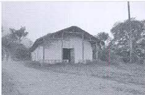
Fotografía nro. 3: Inspección de capilla el Bosque, Arcapamba, Zaruma.
