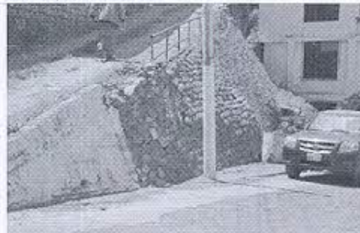
Fotografía nro. 4: Muro de piedra de la ciudad de Portovelo.
